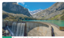
Doc. 1 Barrage hydroélectrique
